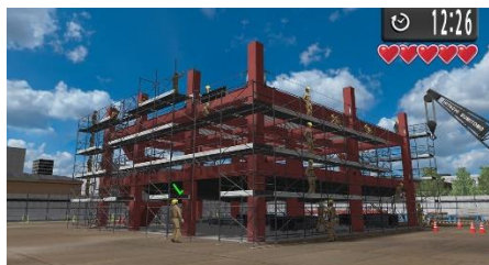
現場内を自由に巡視し 不安全行動や危険箇所を発見
